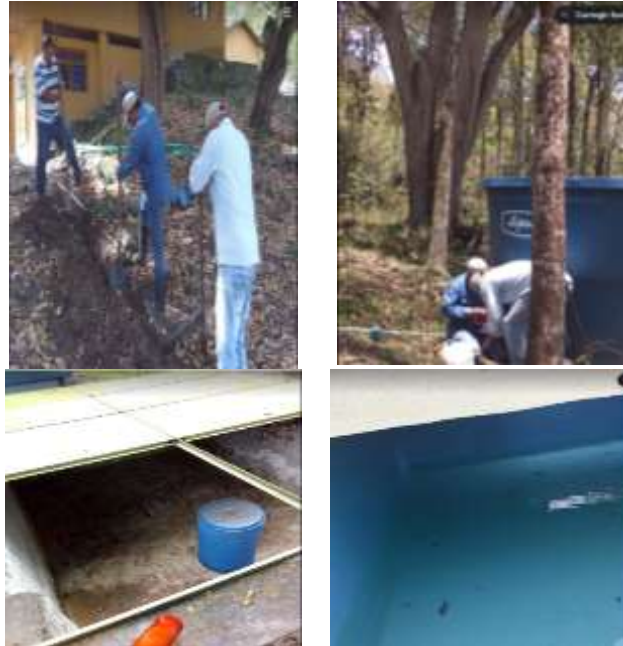
Recuperación del tanque e instalación del tanque de capacidad de 1000 litros
