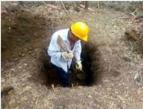
Excavación pozo – prospección Emscalil
