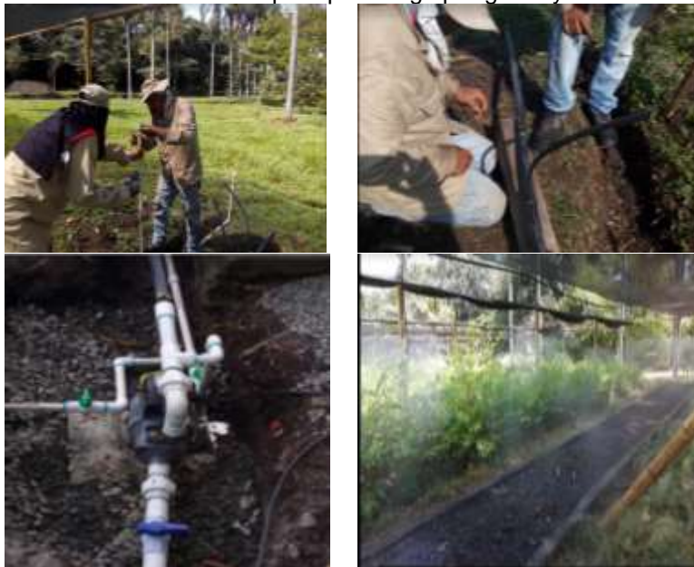
Instalación del riego y nublizadores
