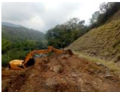
Monitoreo talud parte occidental - Argos
