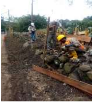
Registro fotográfico en proceso desmonte
