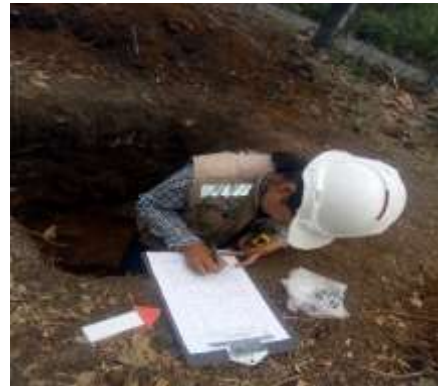
Registro Pozo – prospección Emscalil
