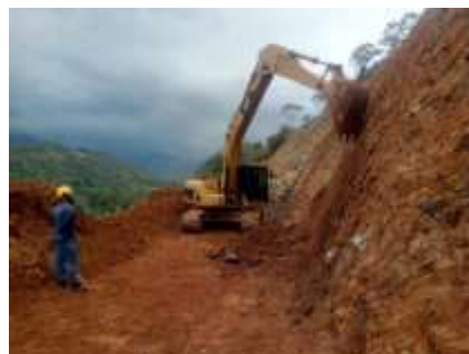
Monitoreo talud parte oriental del predio – Argos
