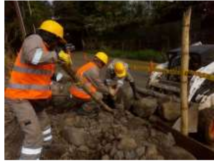
Proceso de desmonte rocas parte muro superior
