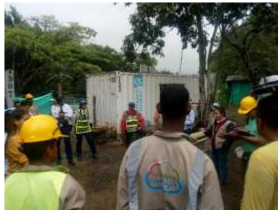
Socialización al personal de obra
